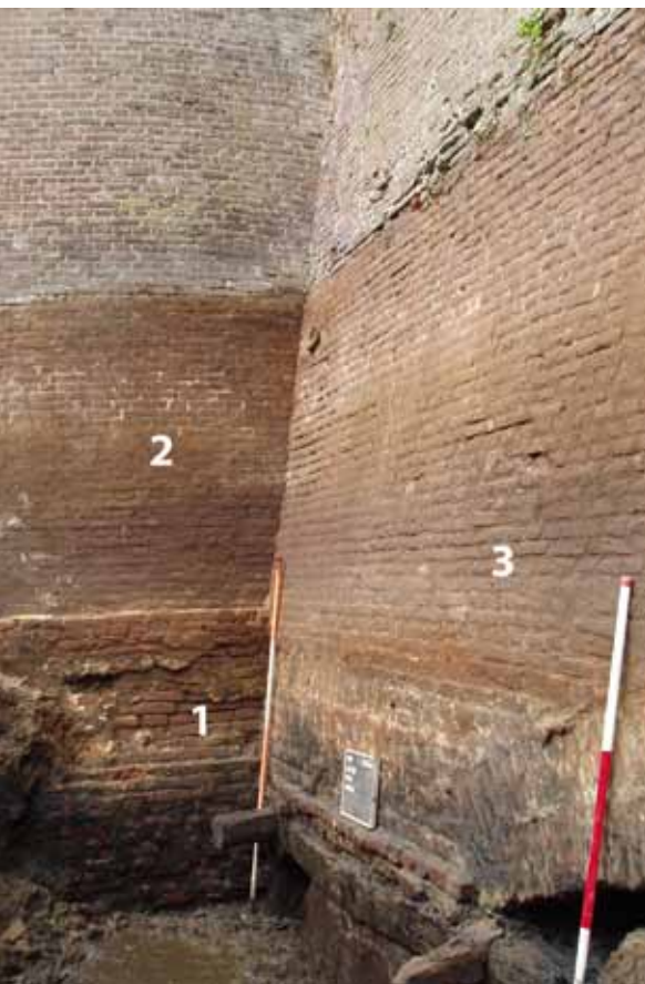
Afb. 3. Rondeeltoren bij de Bethaniëstraat, gezien vanaf de wal. 1: rondeeltoren, 14e eeuw; 2: stadsmuur, 14e eeuw; 3: kolom met trappgat 14e eeuw; 4: stadsmuur, 17e eeuw. (Foto: BAM, BAAC)
